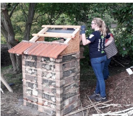
Bau eines Insektenhotels in Westerloy
