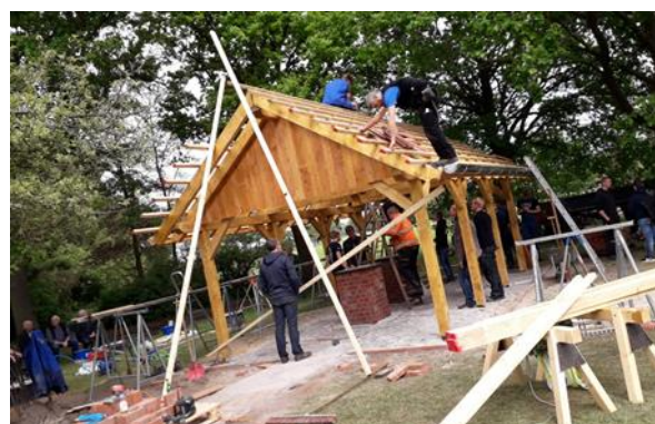
Erstellen eines Grillplatzes in Westerloy
